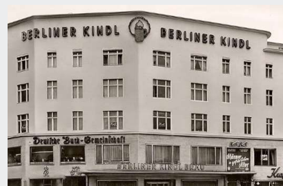
Sanierung Kurfürstendamm 225/226, Berlin
