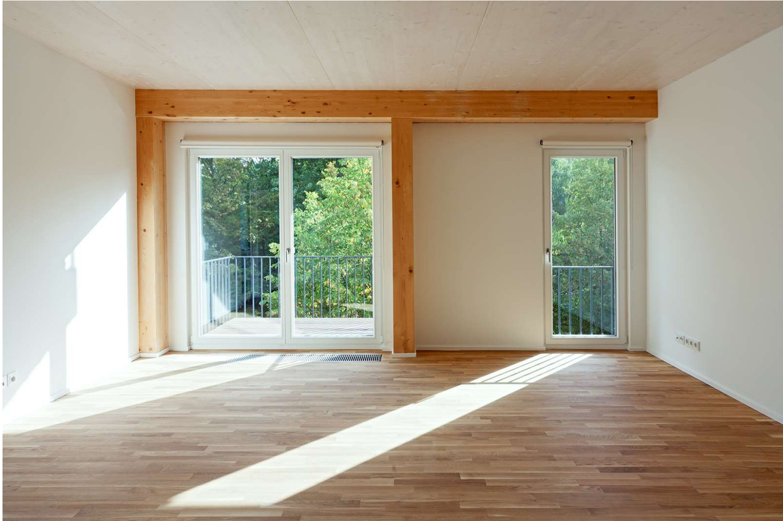
Sichtbare Tragkonstruktion im Projekt Quartier Wir in Berlin, Deimel Oelschläger Architekten
