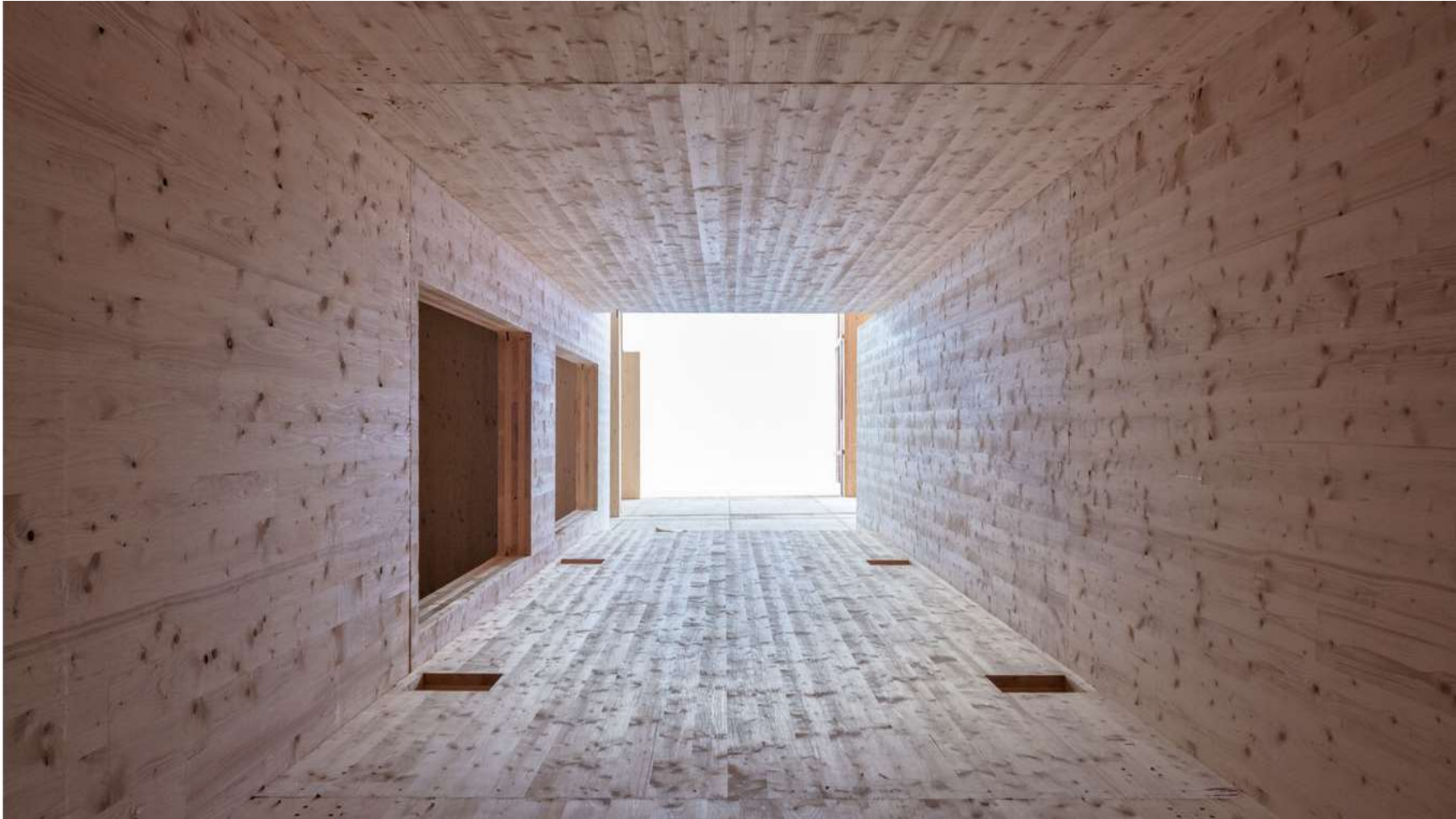
Aufzugsschacht im Projekt Walden 48 in Berlin, Scharabi Architekten PartG mbB
