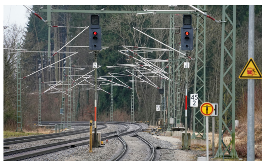
Zwei haltzeitende Hauptsignale an einer elektrifizierten Bahnstrecke (Quelle: Deutsche Bahn AG/Volker Emersleben)
