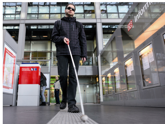
Blindenleitstreifen im Berliner Hauptbahnhof (Quelle: Deutsche Bahn AG/Oliver Lang)
