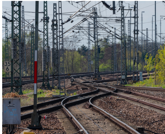
Elektrifiziertes Gleisvorfeld des Bahnhofs Nauen, HVL (Quelle: S. Elm/VBB GmbH)
