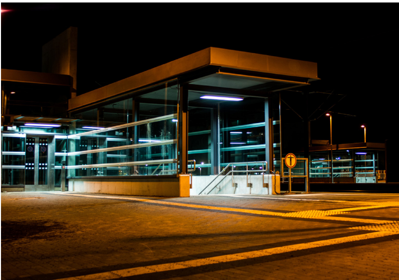
Modernisierte Station Rangsdorf, TF, bei Nacht (Quelle: Aberle – stock.adobe.com)
