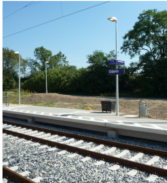
Bei der Modernisierung von Stationen muss das Bahnsteighöhen- und –längenkonzept beachtet werden, wie hier in Oderin, LDS (Quelle: VBB GmbH)
