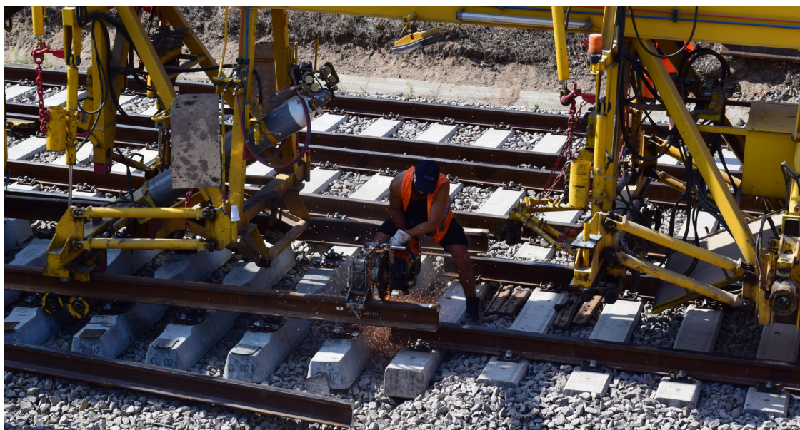
Bauarbeiten an der Eisenbahn-Infrastruktur sind unerlässlich für einen zuverlässigen SPNV (Quelle: Deutsche Bahn AG/Markus Kehnen)
