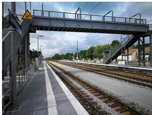
Modernisierte Station Lauchhammer, OSL (Quelle: VBB GmbH)
