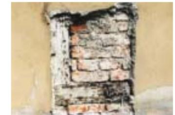
Fotos 23 u. 24: Im Zuge der Sanierung wurde erst erkennbar, wie stark manche Stadtkerne, wie zum Beispiel Templin, durch Fachwerk geprägt sind. Nicht selten wurde es, wie hier in Wittstock, hinter bröckelndem Putz hervorgeholt.
