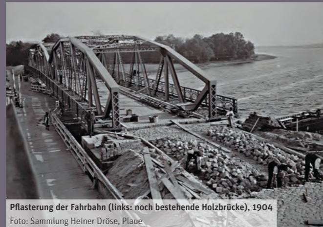
Pflasterung der Fahrbahn (links: noch bestehende Holzbrücke), 1904
