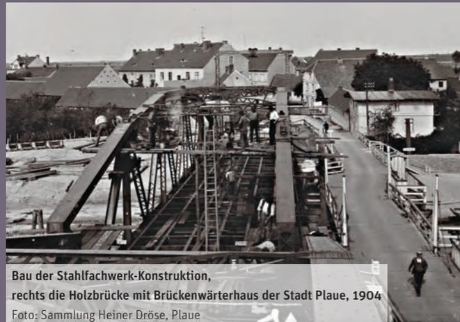
Bau der Stahlfachwerk-Konstruktion, rechts die Holzbrücke mit Brückenwärterhaus der Stadt Plaue, 1904
