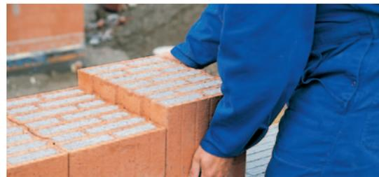
*Bei hochdämmenden Ziegelbaustoffen sind die Hohlkammern mit Wärmedämmmaterial verfüllt.*
