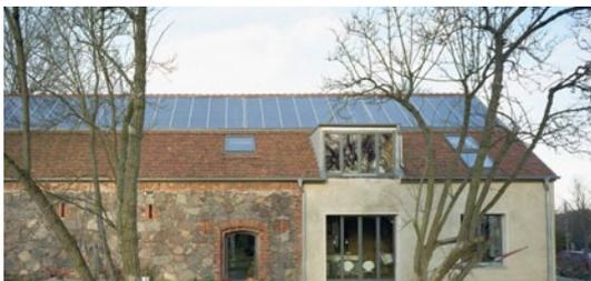
*Anbau in Stampflehbauweise an eine historische Feldsteinscheune in Ihlow, Brandenburg. Die dachintegrierten Solarwärmekollektoren heizen in Kombination mit einem Zentralkamin (Stückholz) das Gebäude über Fußboden und Wandheizung.*
