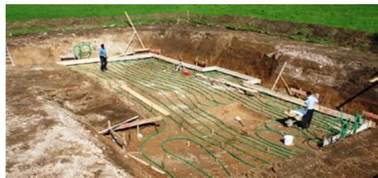
*Verlegung eines Erdwärmeregisters unter der späteren Bodenplatte.*
