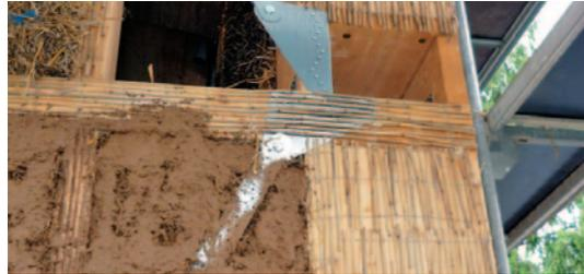
*Aufbauvariante einer Außenwand aus Holzkonstruktion, Strohballen, Strohmatten und Lehmputz.*
