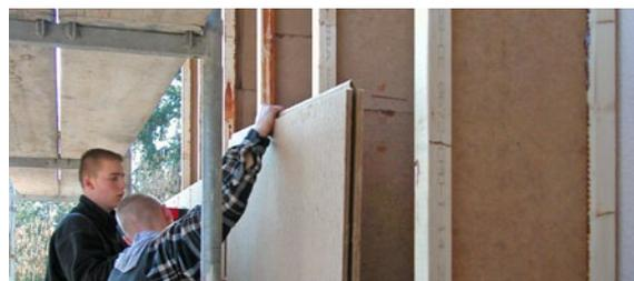
Aufbau eines Holzgefachs zur Befüllung mit Einblas-Dämmstoff
