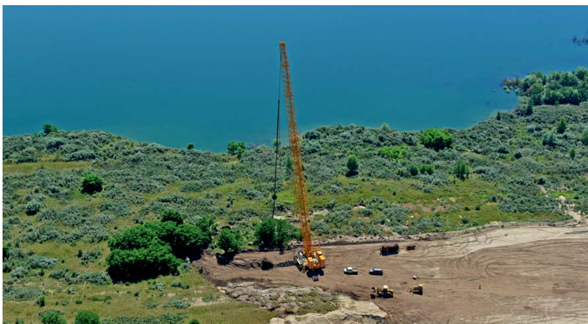
Rütteldruckverdichtung am Restloch Greifenhain © LMBV/Radke
