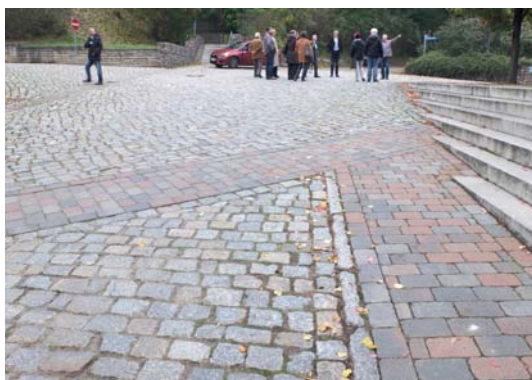
Sanierter öffentlicher Stadtraum, hier in Lebus (Landkreis Märkisch Oderland, Foto: MIL)
