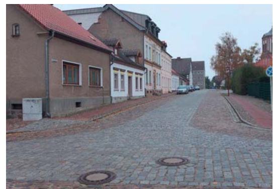
Diese Straße in Gartz (Oder) wurde im Zuge der Stadtkernsanierung erneuert (Landkreis Uckermark, Foto: Hans-Joachim Stricker)
