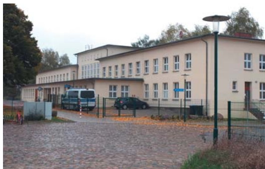
Instandsetzung und Umnutzung mit Hilfe der Städtebauförderung – der Bahnhof in Pritzwalk (Landkreis Prignitz, Foto: MIL)
