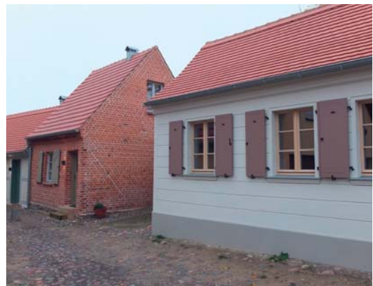
In Kyritz (Landkreis Ostprignitz-Ruppin) wurden die sanierten Budenhäuser zu neuen Wohneinheiten verbunden (Foto: MIL)
