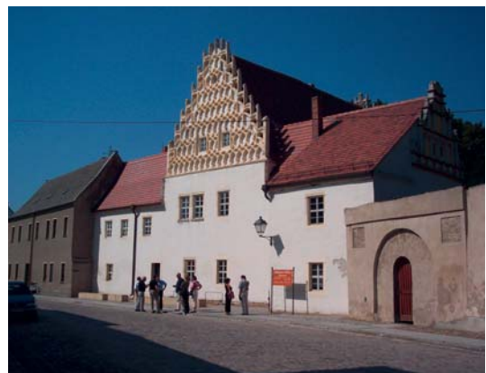
Das Museum in Mühlberg (Landkreis Elbe-Elster) zählt zu den stadtbildprägenden, denkmalgeschützten Großbauten (Foto: MIL)
