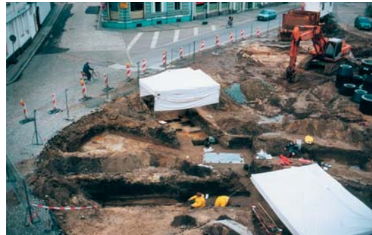
Bild 4: Archäologische Untersuchungen, Freilegung historischer Fundamente
