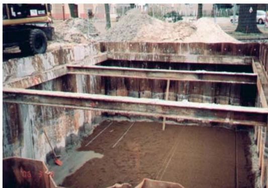
Bild 1: Baugrubenverbau
