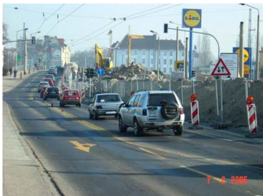
Bild 8 und 9: Baustellensicherung halbseitige Bauweise
