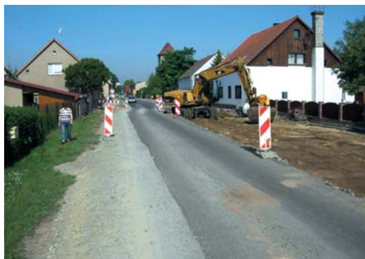
Bild 2: Halbseitige Bauweise mit bauzeitlicher Straßenrandverbreiterung
