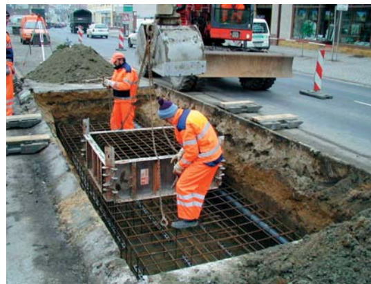
Bild 11: Herstellung eines Fundamentes für eine Verkehrszeichenbrücke
