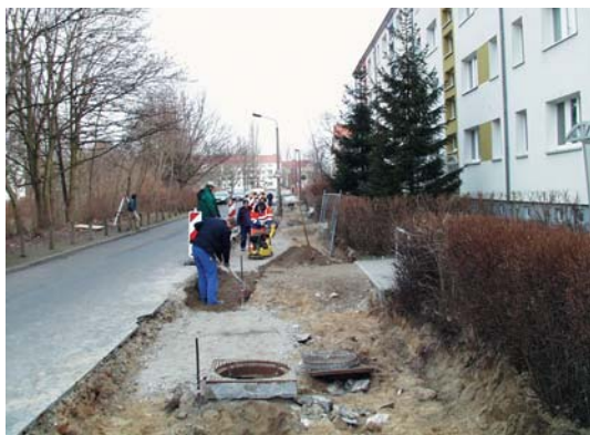
Bild 6: Beispiel Verkehrssicherung Baustellenbereich
