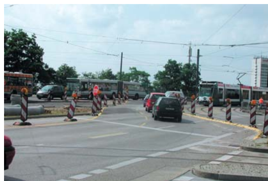
Bild 5: Beispiel Verkehrssicherung Baustellenbereich
