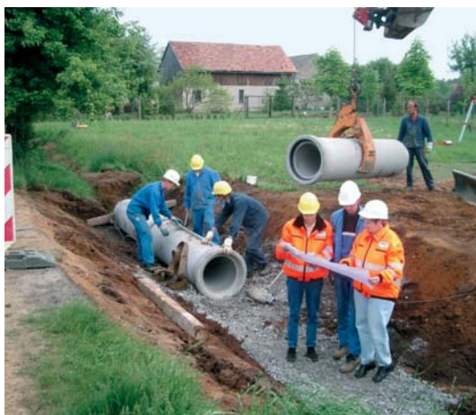
Bild 14: Überwachung einer Baustelle
