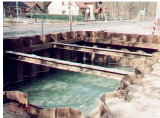
Bild 3: Baugrube mit Grundwasserentnahme
