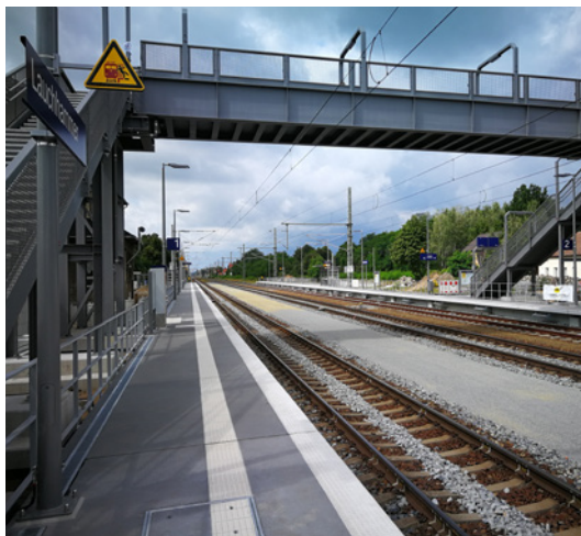
Modernisierte Station Lauchhammer, OS (Quelle: VBB GmbH)
