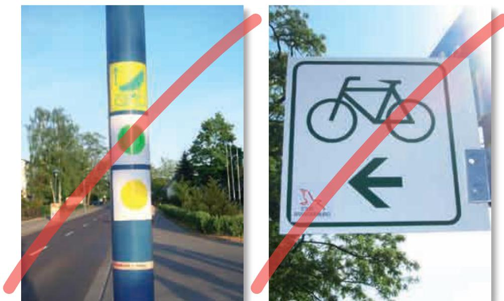
Abb. 2.27: Das Anbringen von Aufklebern auf Zwischenwegweisern und an Pfosten ist nicht zulässig!
