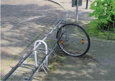
Einfache Vorderradklemmbügel („Felgenkiller“) sind wegen der kurzen Einspannlänge der Felgen gefährlich. Da sie ein Fahrrad statisch nicht stabil halten, kann es leicht seitlich wegklappen und dabei beschädigt werden. Bei bestehenden „Felgenkilleranlagen“ wird wegen des geringen Seitenabstands höchstens jede zweite Halterung genutzt. Dadurch sind weder Kosten noch Platzbedarf günstiger als bei funktionellen Anlehnbügeln. Bestehende „Felgenkilleranlagen“ sind zu ersetzen.
