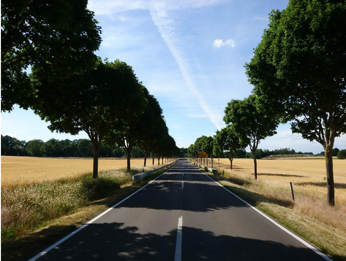
Abbildung 95: Allee an der L88 Abschnitt 050 Kilometer 2,2/2,5 Abstand zur Straße 4 m, Abstand zum Acker 2 m, Abstand innerhalb der Reihe 12 m, Spitzahorn, 28 cm Stammdurchmesser, Straße überwiegend beschattet (14.06.2022, ca. 16 Uhr).
