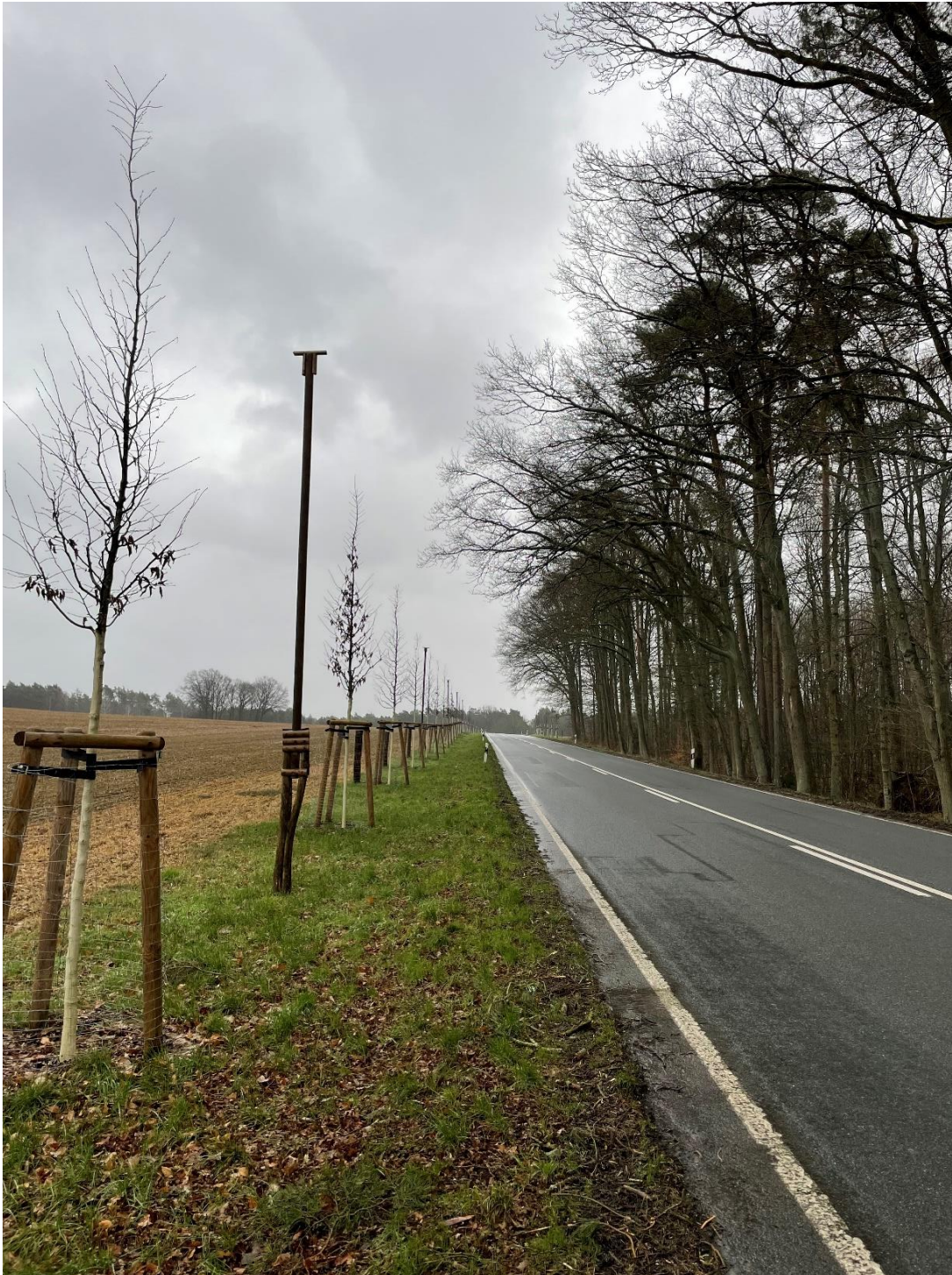
Abbildung 74: Einseitige Baumreihe auf der Feldseite mit gegenüberliegendem Waldbestand (B103, Abschnitt 023, 25.02.2022).
