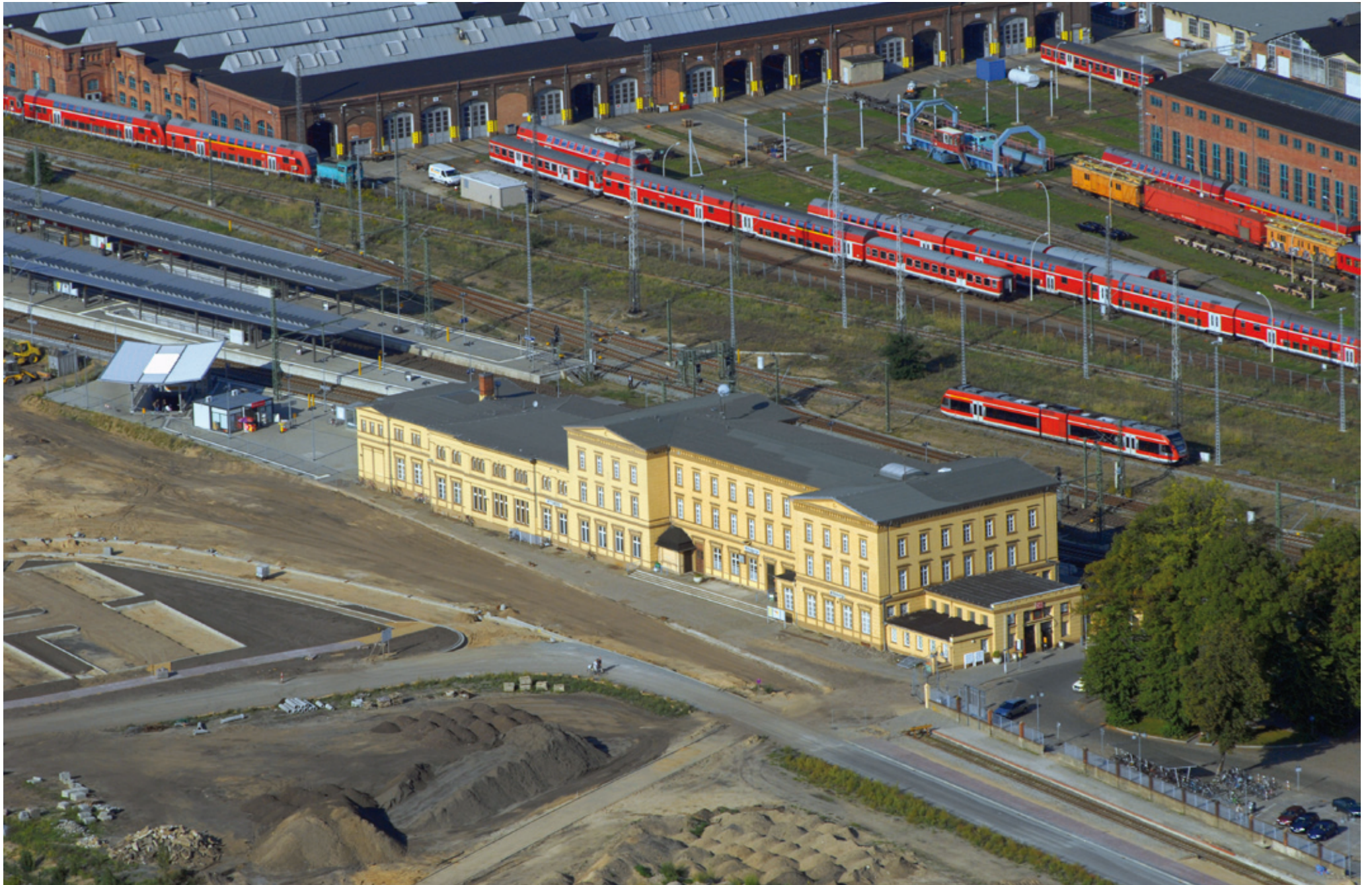
Luftbild kurz nach Abbau des westlichen Gleises,
