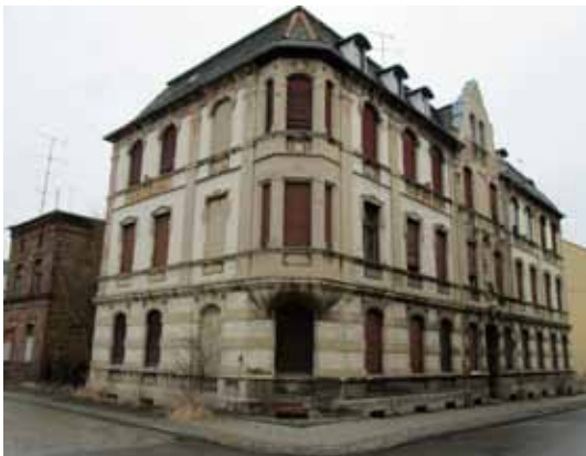
Unsaniertes Altbau in Forst (Lausitz)
