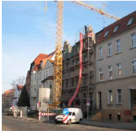
Sanierung eines Altbaus in Pritzwalk
