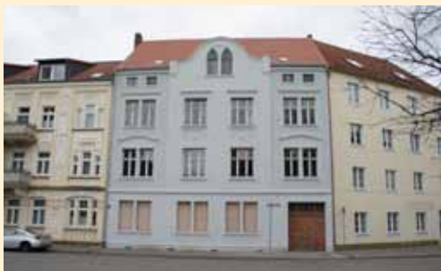
Konserviertes Gebäude Rudolf-Breitscheid-Straße 25
