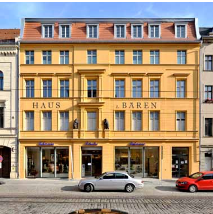
Saniertes Gründerzeithaus in Brandenburg an der Havel
