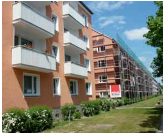
Instandsetzungsmaßnahmen in Eisenhüttenstadt
