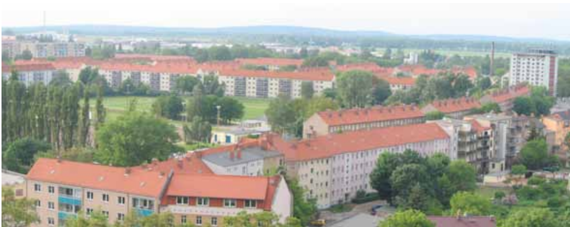
Wohngebiet Brandenburg Nord
