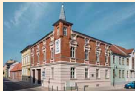
Saniertes ehemaliges Stadthotel
