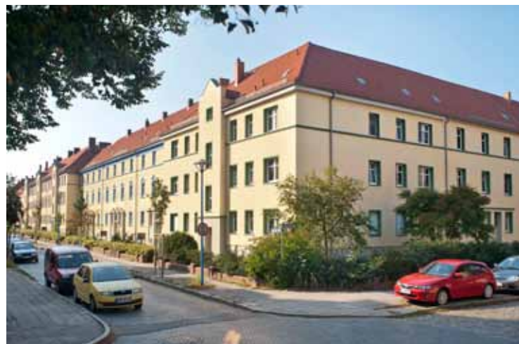
Sanierte Gebäude in Cottbus
