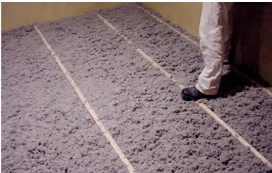
Einblasdämmung Zellulose zwischen Lagerhölzern im Fußboden © Klempnow
