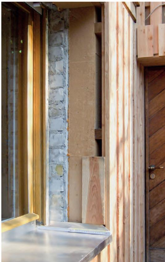
*Dämmung und hinterlüftete Fassade © Klempnow*
