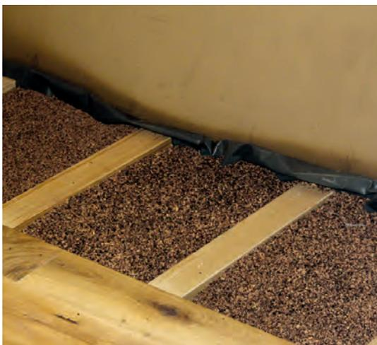
Korkschütttdämmung unter Holzfußboden © Klempnow
