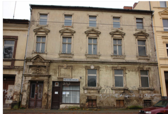
Bauhofstraße 18 und 20 (Gründerzeitlicher Ring)
