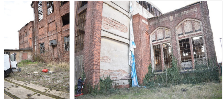
E-Werk, Bauhofstraße 2 (Gründerzeitlicher Ring)
