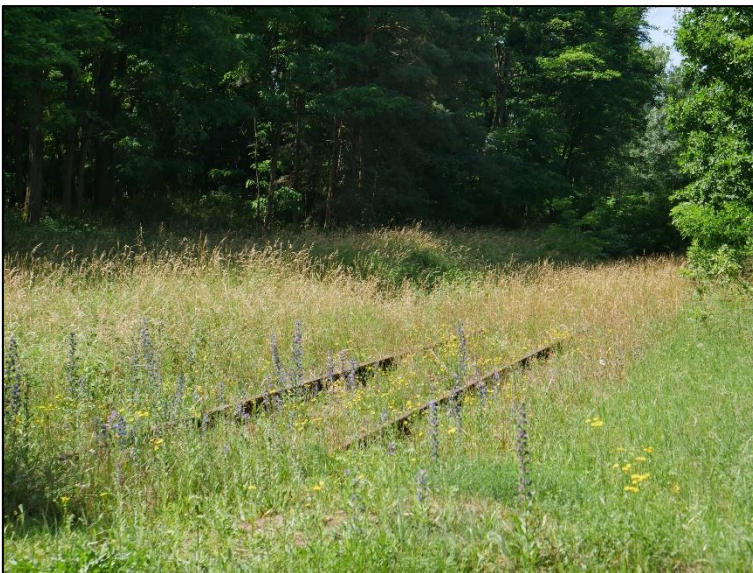
Abbildung 11: typischer Streckenzustand mit viel umgebender Vegetation und abgenutzten Schienen beim Bahnübergang Vevaiser Weg (Blick Richtung Osten)
