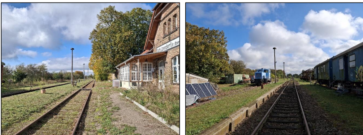
Abbildung 20: Bahnhof Schulzendorf (b Bad Freienwalde) mit abgestellten Fahrzeugen des Museumsvereins
