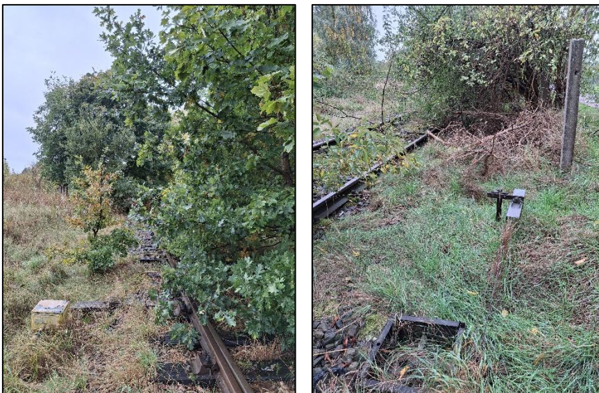
Abbildung 6: stark mit Vegetation bewachsener Abschnitt mit alter Stellwerkstechnik bei Wriezen
