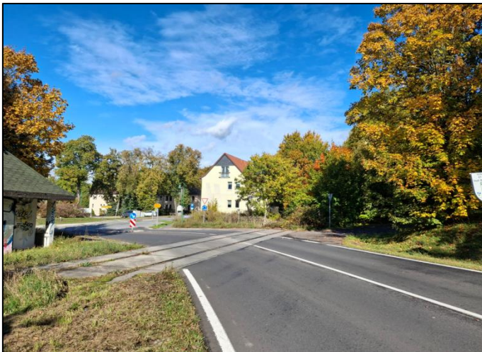
Abbildung 24: ehemaliger Bahnübergang B168 ohne Sicherung
