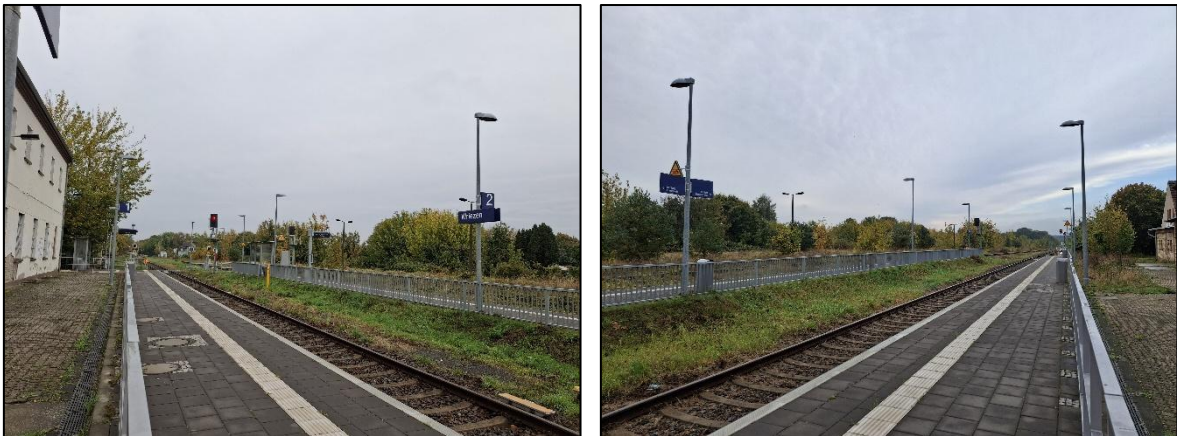
Abbildung 21: aktueller Zustand des Bahnhof Wriezen mit seiner Funktion als Kreuzungsbahnhof der RB60
