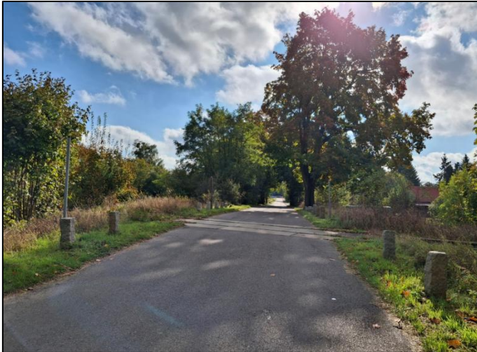
Abbildung 26: ehemaliger Bahnübergang Pflasterstraße / Wriezener Straße ohne Sicherung
