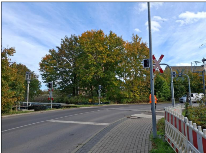
Abbildung 22: Bahnübergang Beiersdorfer Straße mit Lichtzeichen und Andreaskreuz. Es existieren außerdem BÜ-Ankündigungsbaken
