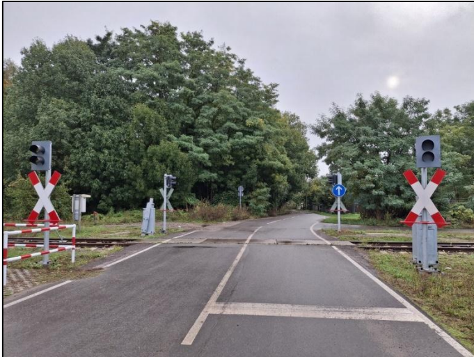
Abbildung 31: unbeschränkter Bahnübergang Schwarzer Weg mit außer Betrieb genommener technischer Sicherung (Lichtzeichenanlage)
