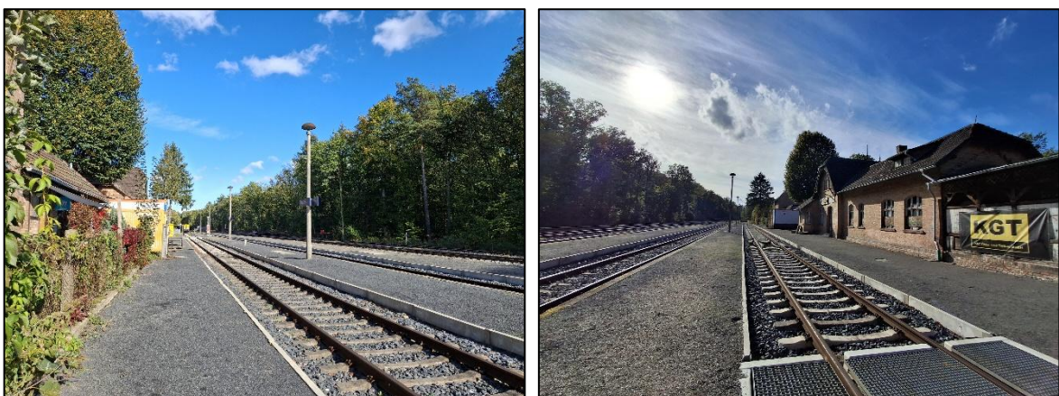
Abbildung 16: der von der KGT für den Güterverkehr genutzte und sanierte Bahnhof Tiefensee
