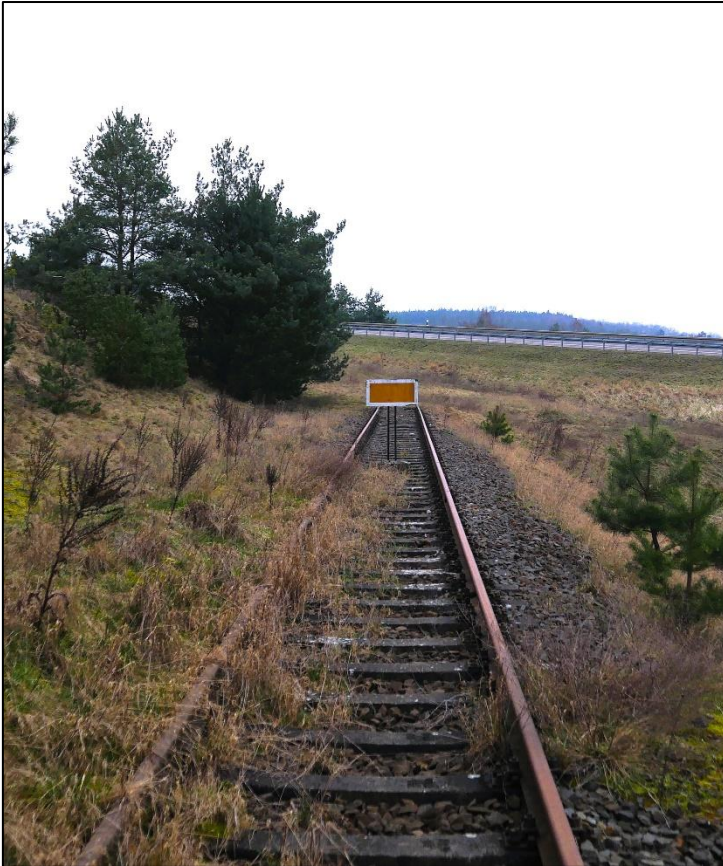
Abbildung 10: durch die Wriezener Ortsumfahrung (B167n) unterbrochener Streckenabschnitt – Südende in Richtung Norden
