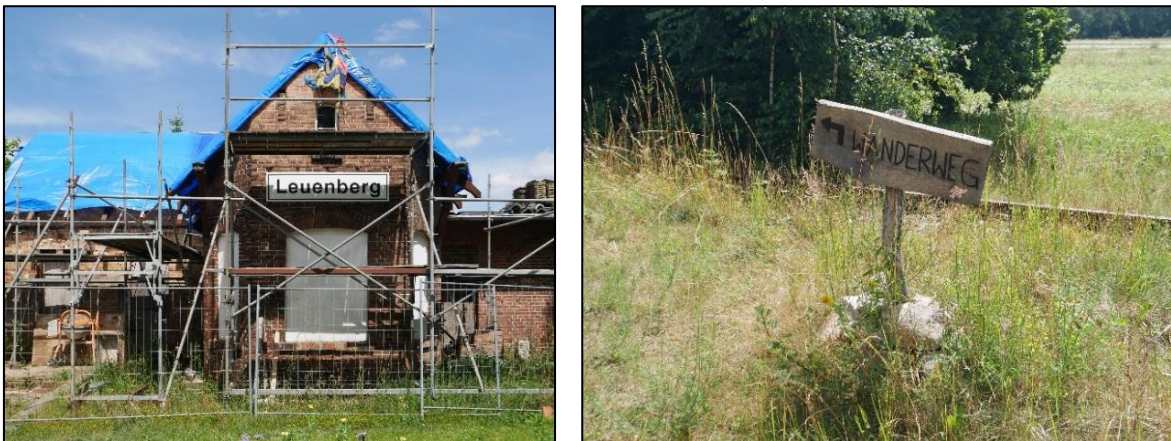
Abbildung 17: ehemaliges Stationsgebäude sowie das Hinweisschild auf den Wanderweg entlang des Bahnsteigs
