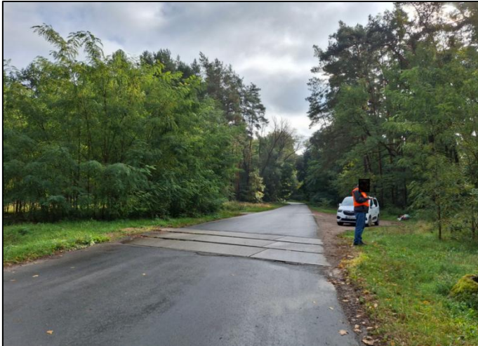
Abbildung 29: ehemaliger Bahnübergang Vevaser Weg ohne Sicherung
