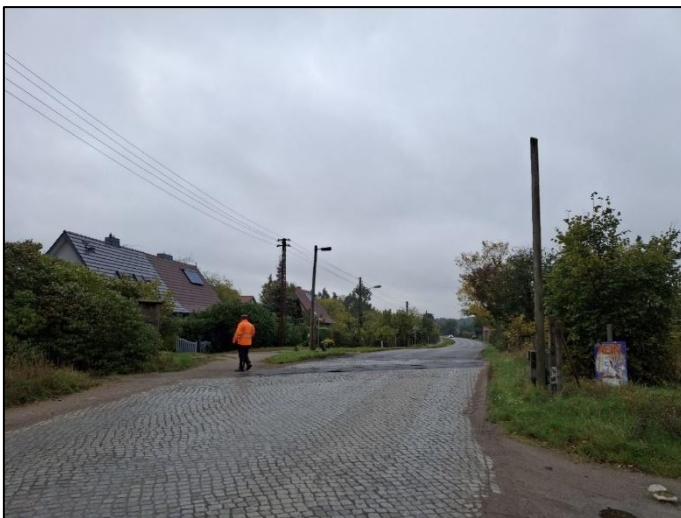
Abbildung 30: ehemaliger Bahnübergang Frankfurter Straße ohne Sicherung
