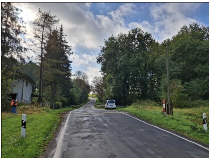
Abbildung 28: ehemaliger Bahnübergang Mögliner Straße ohne Sicherung
