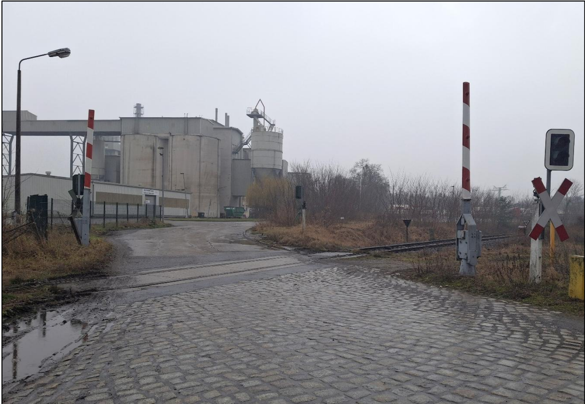
Abbildung 25: Bahnübergang Siedlerweg mit Lichtzeichen und Halbschranken (WSSB-Anlage)
