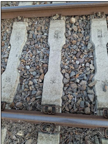
Abbildung 7: Intakte Schienen und Schwellen unterschiedlicher Bauform
