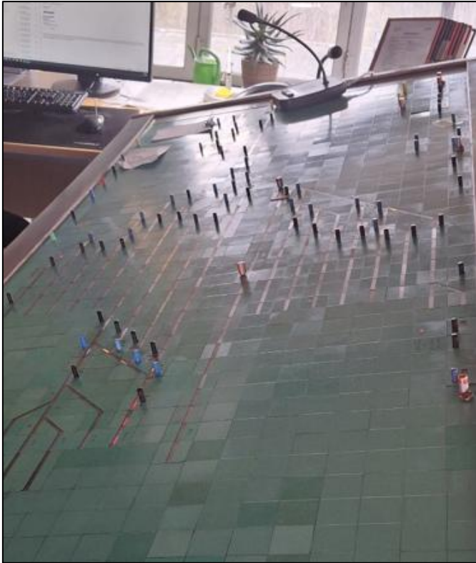
Abbildung 29: Relaisstellwerk des Bahnhof Rüdersdorf (b Berlin)
