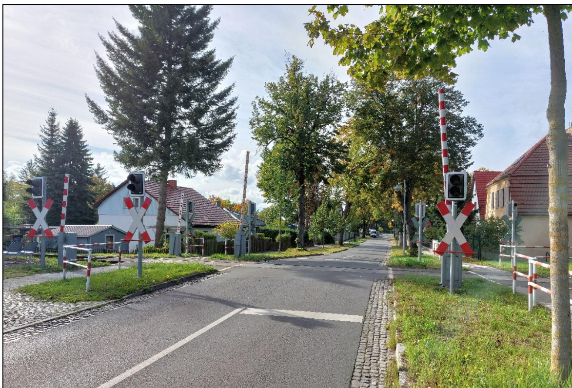
Abbildung 21: Bahnübergang Wilhelm-Pieck-Straße mit Lichtzeichen und Halbschranken
