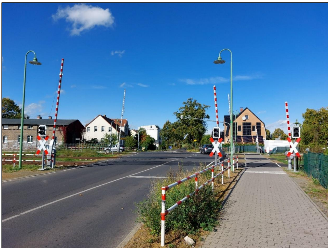
Abbildung 19: Bahnübergang Lindenstraße mit Lichtzeichen und Vollschranken
