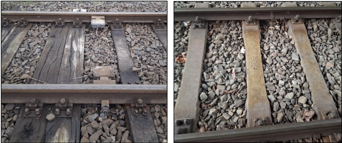
Abbildung 15: Holzschwellen und Betonschwellen auf der Strecke der CEMEX-Werksbahn
