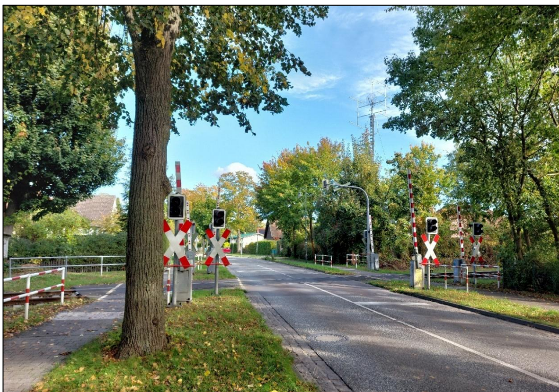
Abbildung 20: Bahnübergang Eggersdorfer Straße mit Lichtzeichen und Halbschranken
