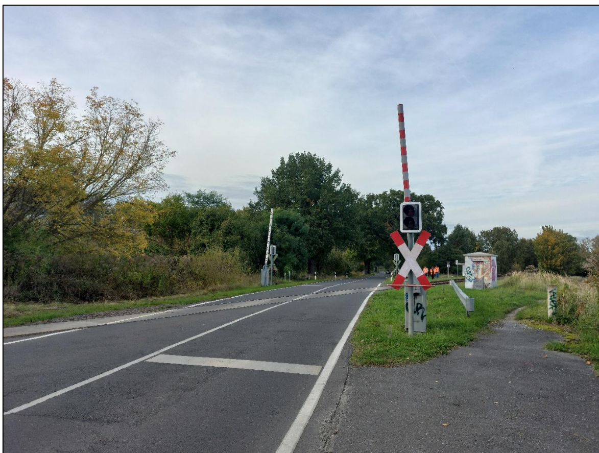
Abbildung 22: Bahnübergang Tasdorfer Straße/L30 mit Lichtzeichen und Halbschranken
