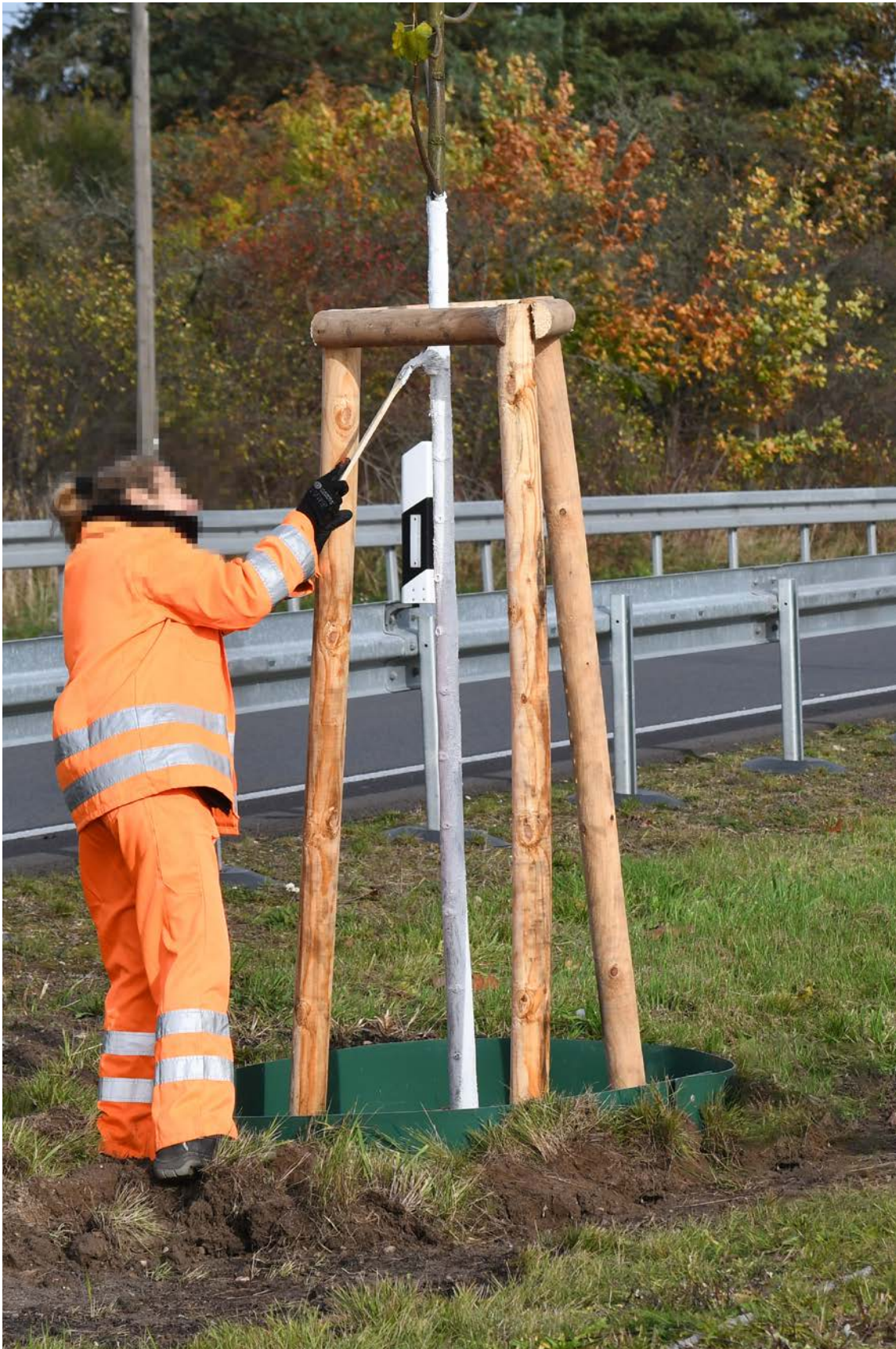
Baumarbeiten an der B246
