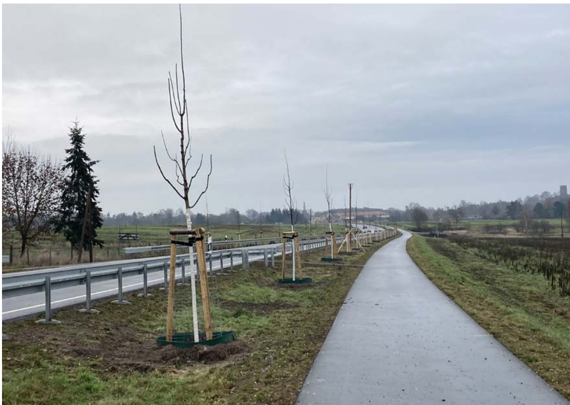
B246 Ausblick auf den Radweg Richtung Bad Belzig inklusive neu gepflanzter Bäume
