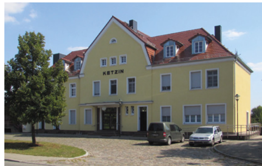
Die stillgelegte SPNV-Strecke Ketzin – Wustermark (beides HVL) wird einer detaillierten Prüfung unterzogen (Quelle: Gregor Rom, CC BY-SA 4.0, Wikimedia)
