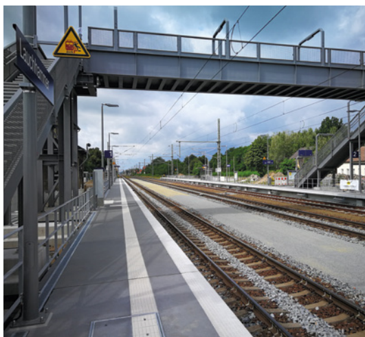
Modernisierte Station Lauchhammer, OSL (Quelle: VBB GmbH)
