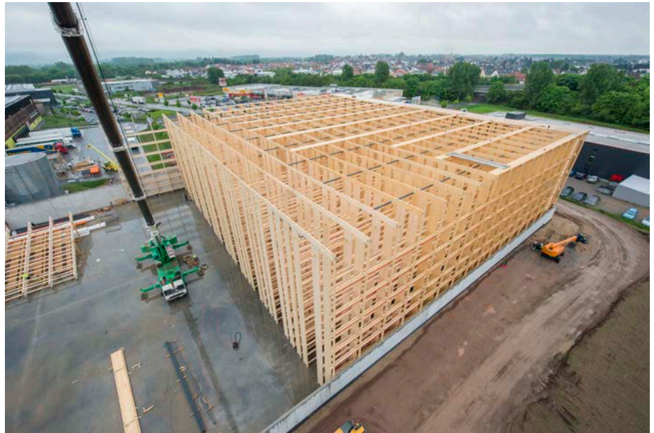
Alnatura Hochregallager von BFK Architekten
