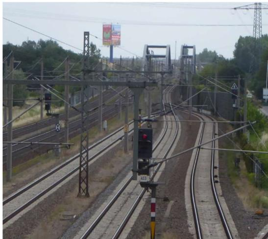
*Abbildung 7: Die eingleisige Brücke der Stammbahn Berlin-Stendal (rechts im Hintergrund) muss bei einem Ausbau der Stammbahn für den Güterverkehr ohnehin durch ein zweites Brückenbauwerk ergänzt werden. Dabei kann der Bahnhof Wustermark (Vordergrund) angepasst werden.*
