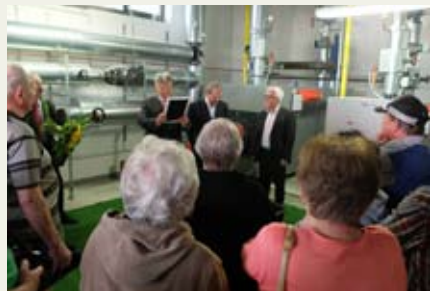
Führung durch das neue Heizhaus am Tag der Städtebauförderung in Wittstock/ Dosse (Quelle: B.B.S.M.)
