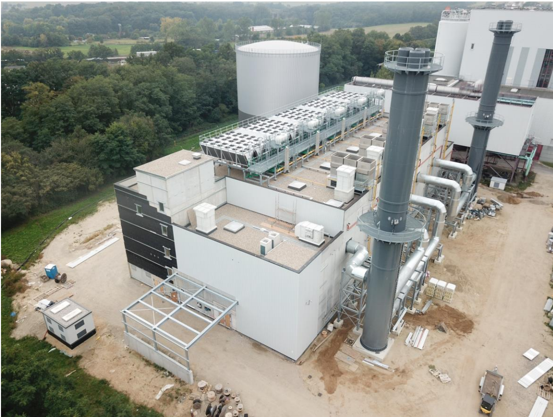
Ansicht Nord-Ost, Drohne Okt. 2021
